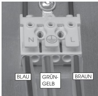
Links befindet sich der Nullleiter (N), blaues Kabel. In der Mitte befindet sich die Erdung, grün-gelbes Kabel. Rechts befindet sich die Phase (L), braunes oder schwarzes Kabel.
